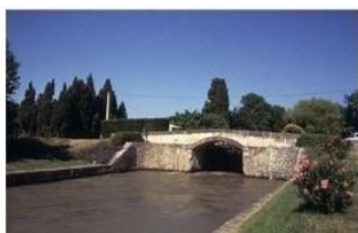
Sortie aval de l'écluse de Tréboul
