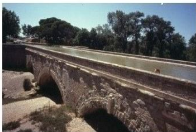
Pont canal sur la Cesse (1693)
