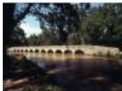
Déversoir de l'Argendouble (1694)
