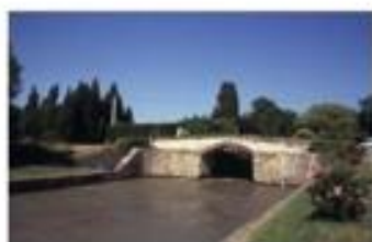
Sortie aval de l'écluse de Tréboul
