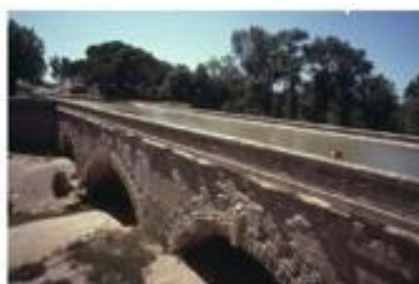
Pont canal sur la Cesse (1693)
