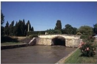
Sortie aval de l'écluse de Tréboul
