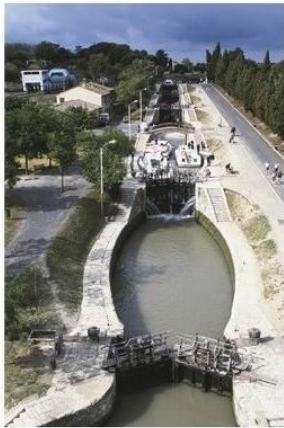
Ecluse octuple de Fonsérannes (1678-1680)
