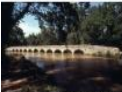
Déversoir de l'Argendouble (1694)
