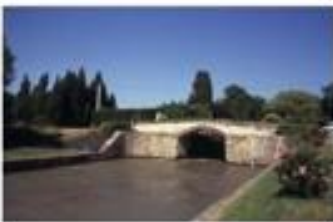
Sortie aval de l'écluse de Tréboul
