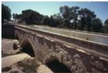
Pont canal sur la Cesse (1693)
