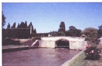
Sortie aval de l'écluse de Tréboul
