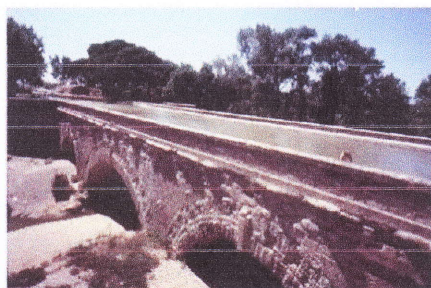
Pont canal sur la Cesse (1693)
