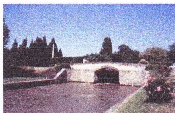
Sortie aval de l'écluse de Tréboul
