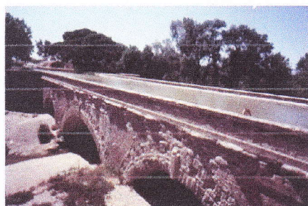
Pont canal sur la Cesse (1693)
